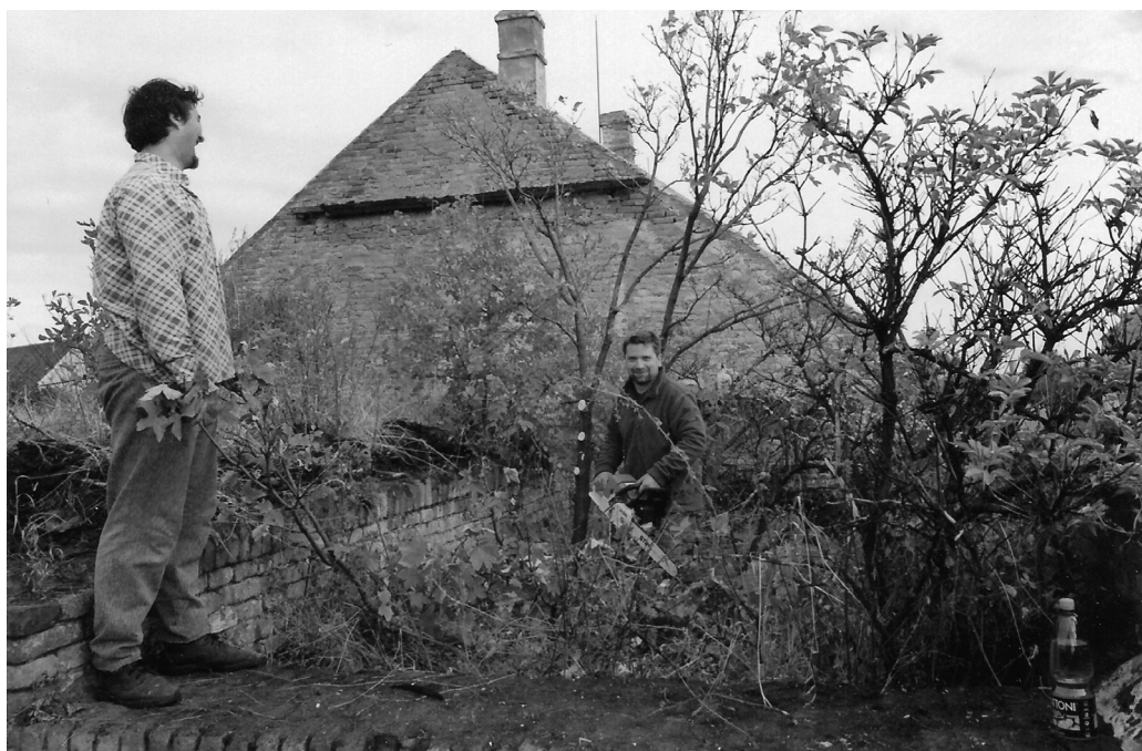
Obr. 7. Vyklízení místy propadeného stropu stáje s porostem keřů, stromů a téměř 40 cm mocnou vrstvou popela, hlíny i tašek. Magistři L. Kratochvíl a R. Šohaj odstraňují náletové dřeviny a připravují prostor ke kompletnímu vyčištění. Foto: B. Klíma.
