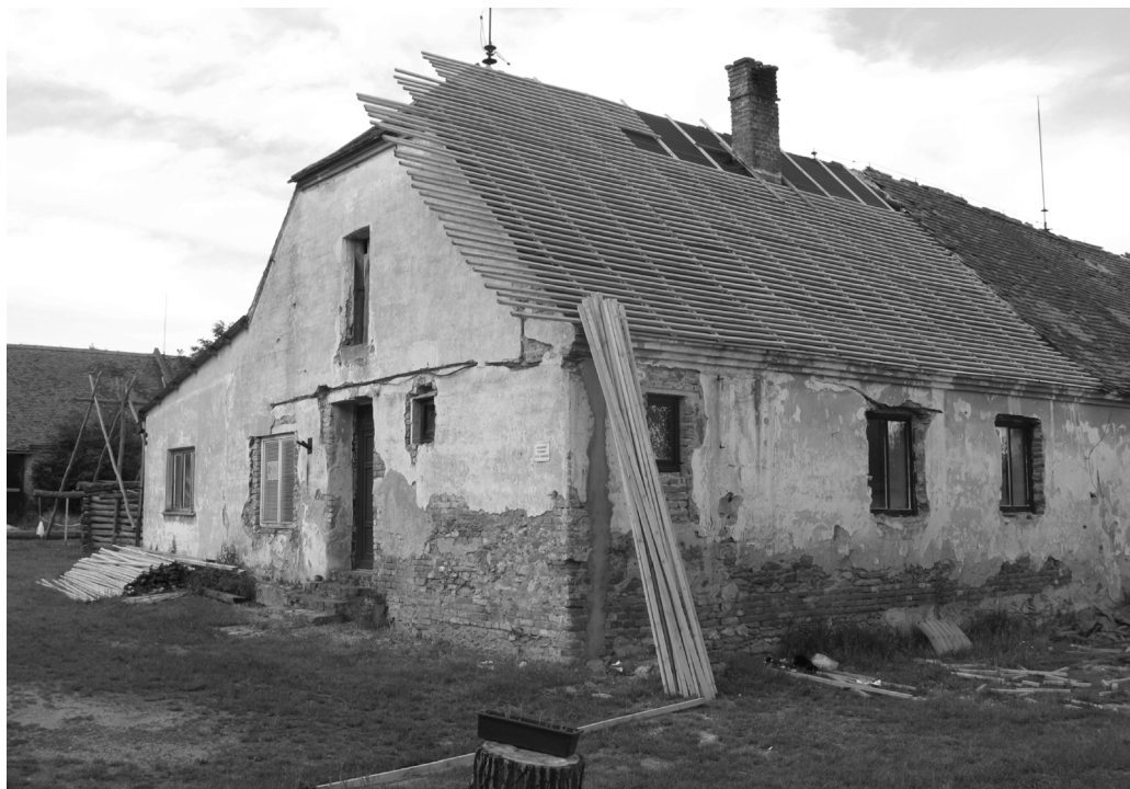
Obr. 4. Výměna staré, propadené střechy na rodinném domě, dnes studentské části expedice – ubytovně. Foto: B. Klíma.
