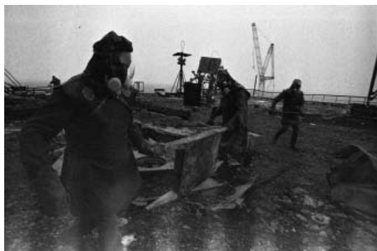
Obr.6 Hasiči na hořící střeše reaktorové budovy.
