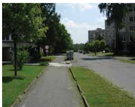
Obr. 8 Význačený zbytečný přechod pro chodce přes vjezd do objektu
