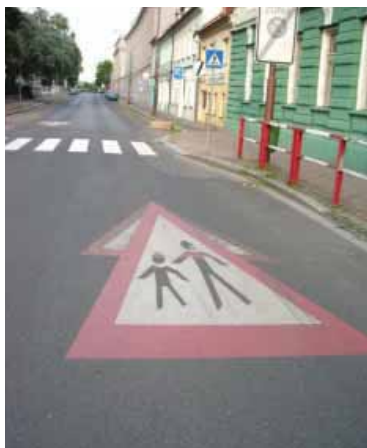
Obr. 3 Špatně odstraněné dopravní značení
