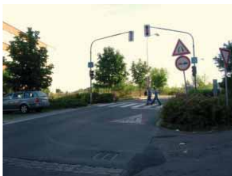
Obr. 22 – Upravený přechod před školou – světelná signalizace, dopravní značení
